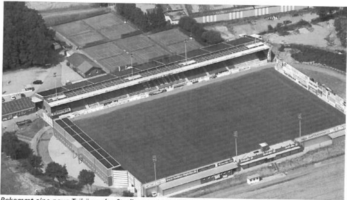
Bekommt eine neue Tribüne: das Stadion am Lotter Kreuz. Foto: Gert Westdörp
