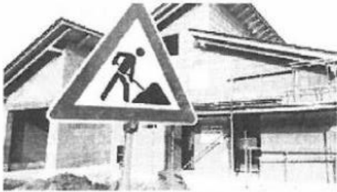
Baustellenschild vor dem Rohbau eines Einfamilienhauses
