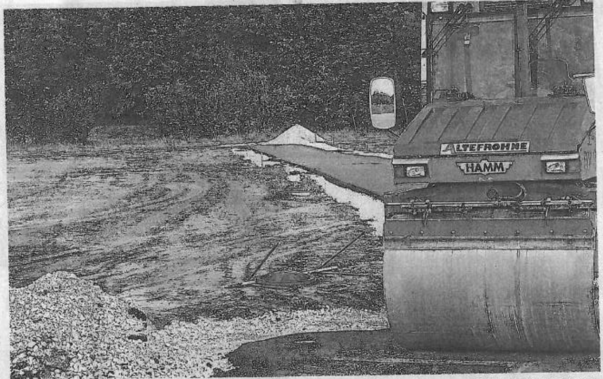
Die Erschließung von Baugebieten wie hier 2009 in Hohne umfasst zahlreiche Leistungen. Welche den Grundstückskäufern in welcher Höhe in Rechnung gestellt werden dürfen, das ist im aktuellen Rechtsstreit die Frage. Foto: ws-
